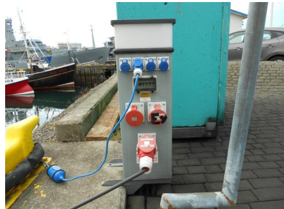
Mynd 5 - Tengiskápur, búnaður til landtenginga í Faxaflóahöfnum.
