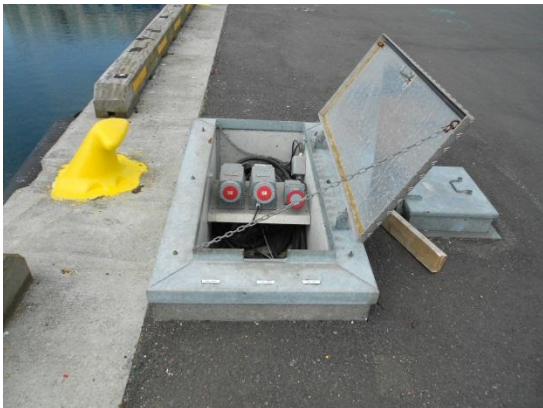
Mynd 4 - Tengibrunnur, búnaður til landtenginga í Faxaflóahöfnum.
