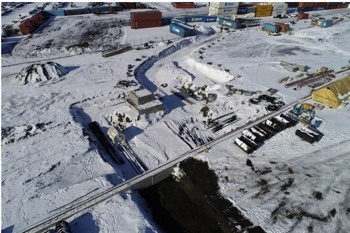
Mynd af suðurenda á nýjum hafnarbakka utan Klepps þar sem unnið er að frágangi á veitutengingum og áformað að nýr Gantry krani verði skipað á land og hann settur saman.
